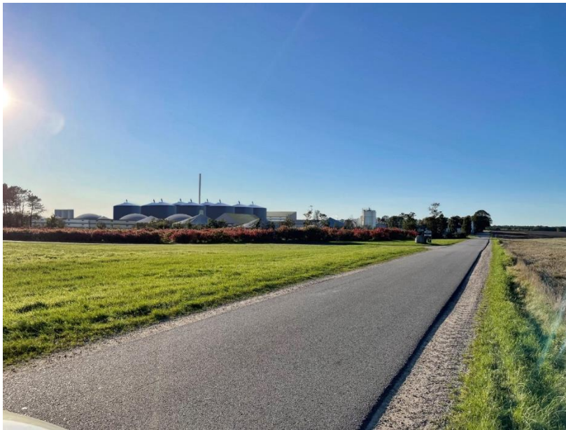
Anlægget set fra øst på Østenfjeldvej.
