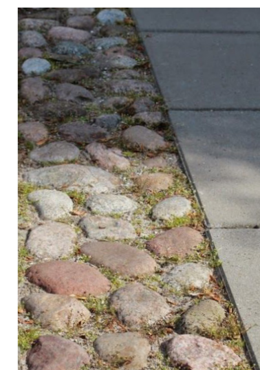
Eksist. belægning i betonsten opløses med belægning i knoldebro og grus
